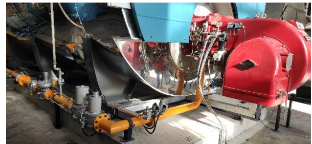
شکل ۲۳- مشعل مادولار با ظرفیت ۱۰ مگاوات و نسبت تبدیل ۱:۱۰ نصب شده روی بویلر بخار، ساخت شرکت پاکمن
