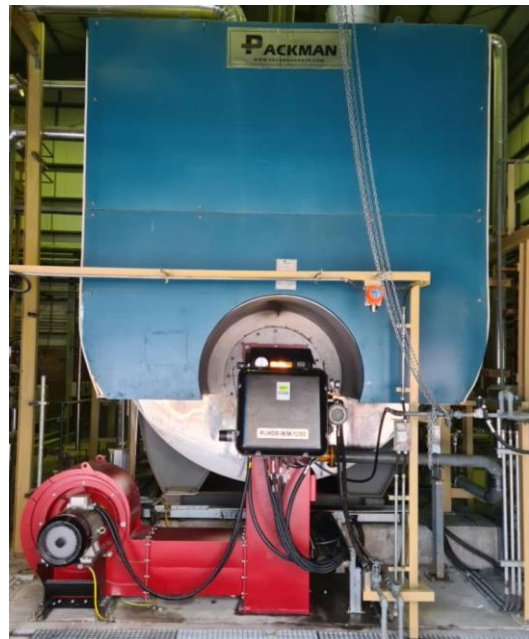
شکل ۳۸: مشعل شعله کوتاه بر روی ساختار دوال بلاک، با ظرفیت ۱۲ مگاوات بر روی بویلر بخار با ظرفیت ۱۴ تن بخار در ساعت، ساخت شرکت پاکمن
